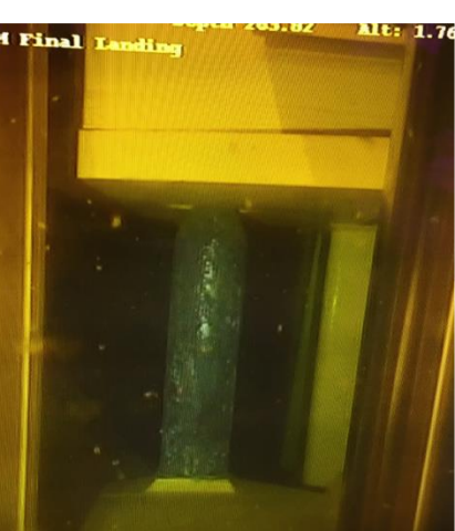
«Pin» & «Knife» fine alignment - during final lowering (~50cm)
