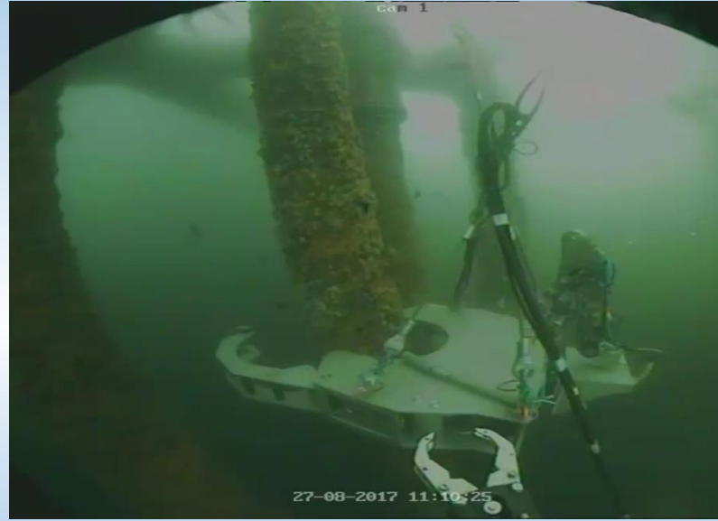
Posisjonering og clamping på caisson
