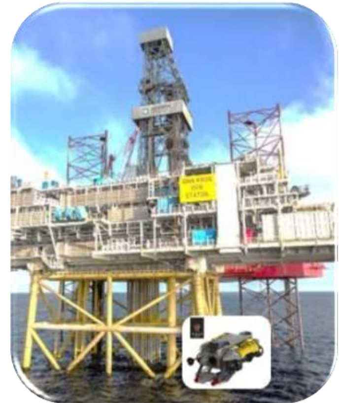
miniROV –for inspeksjon av plattformstruktur
