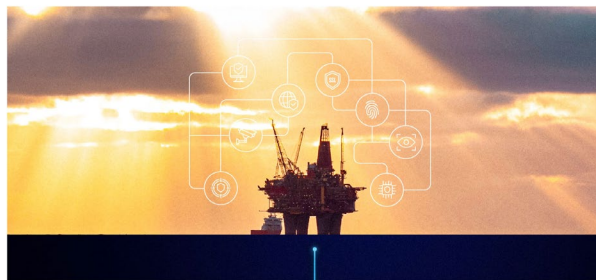
FOTO: GETTY IMAGES. Fokus på sikkerhet rundt vår egen infrastruktur har økt, og myndighetene har flere ganger det siste året bedrevet en økt trussel rettet mot olje- og gassinfrastruktur. Dette gjelder all kritisk infra-struktur, og spesielt infrastruktur tilknyttet eksport av energi til Europa. Underjordisk infrastruktur som røretninger som frakter olje, gass, samt fiberkabler er også sårbare.
