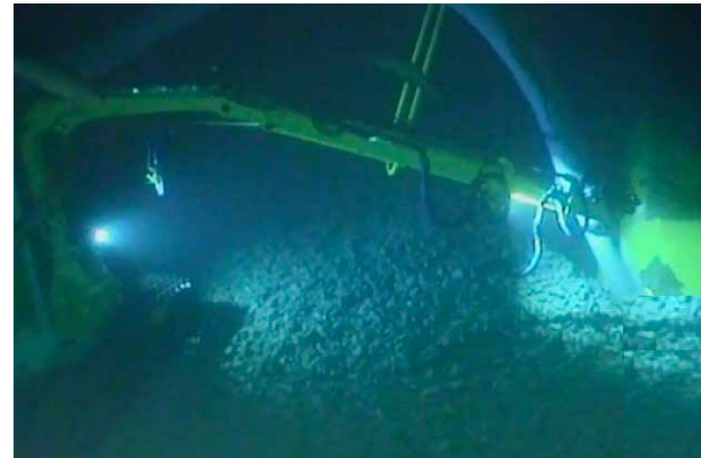
Dredging av rock dump rundt protection cover.
