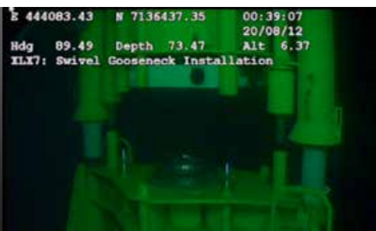
Installasjon av svivel på toppen av BTen.
