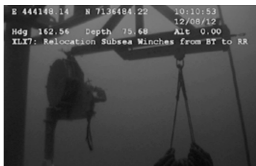
Flytting av undervannsvinsjer fra nedre del av BT til Riser.
