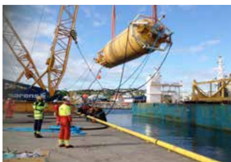
Utlasting av Framo Buoyancy Tank (BT).
