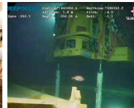
Juletreet entrer nedpå guidepostene under installasjon.
