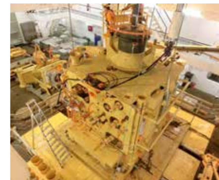
Juletreet klargjøres for installasjon.
