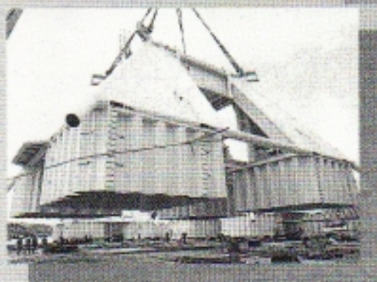
Beskyttelsesstruktur for Tordis satellittbrønner.
