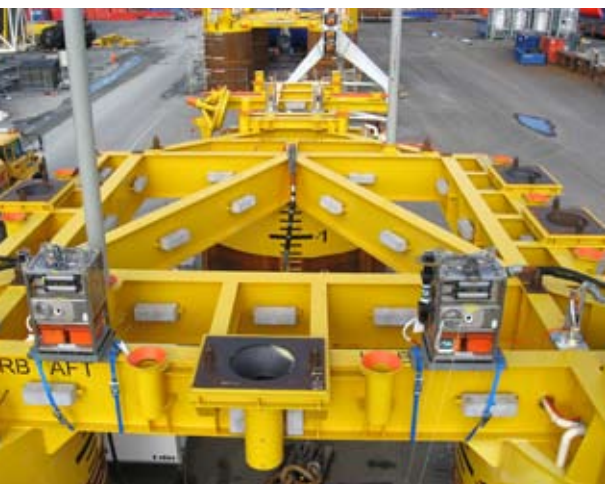
SDM installert på URB, Skarv.
