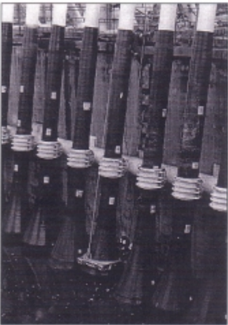
Inntrekkingsrørene er festet til platformen med klammer. Prosjektet gikk ut på å forsterke disse med ekstra bøyleklammer mellom rammen og inntrekkingsrøret og la de opprinnelige klammerne være urørt.
