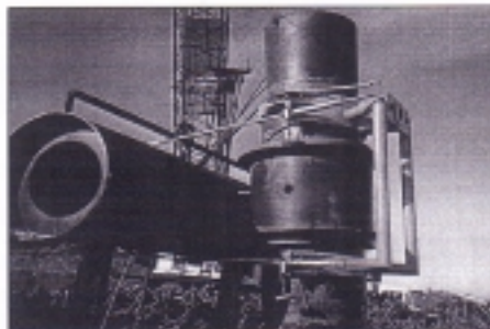
Klammer for import rør montert på fullskalamodell. På toppen av den horisontale innfestingsrammen er der montert en anode som bøylen måtte treies gjennom. Arbeidet ble utført av WORO:
