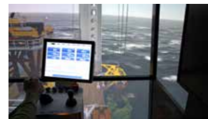
Kompressor-modul er nå kommet gjennom skvalpesonen.
