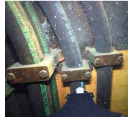
Detaljinspeksjon av kabelklammer.
