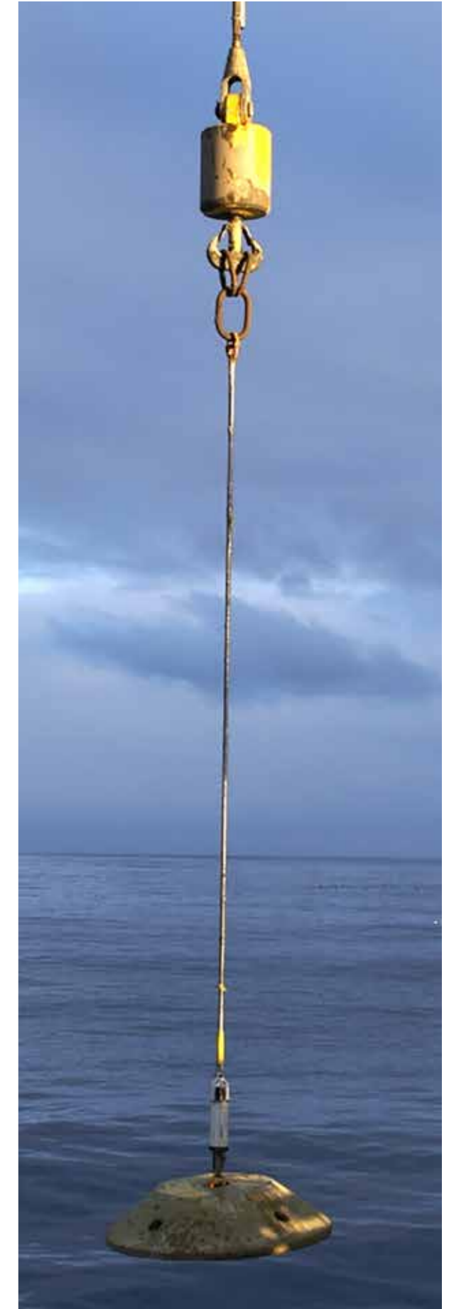
Figur 3: Nedsenkning av betongfundament med kran fra fartøyet gjennom skvalpesonen (Troll gravimetri, 2012).
