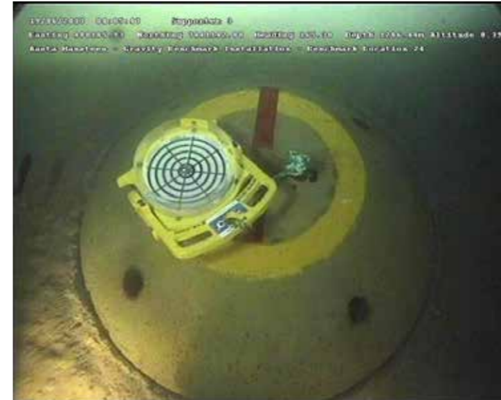
Figur 2: Betongfundament plassert på havbunn på Aasta Hansteen. Bullseye inklinometer blir brukt til å verifisere optimal posisjonering.
