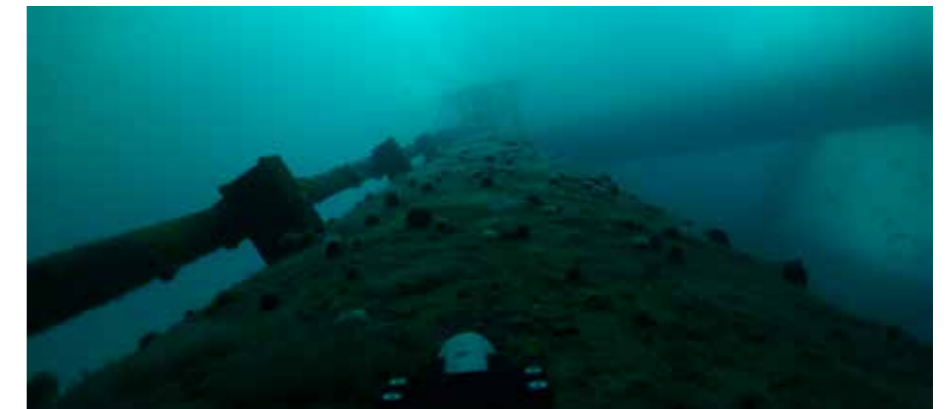
Oversiktsbilde opp langs plattformbein.
