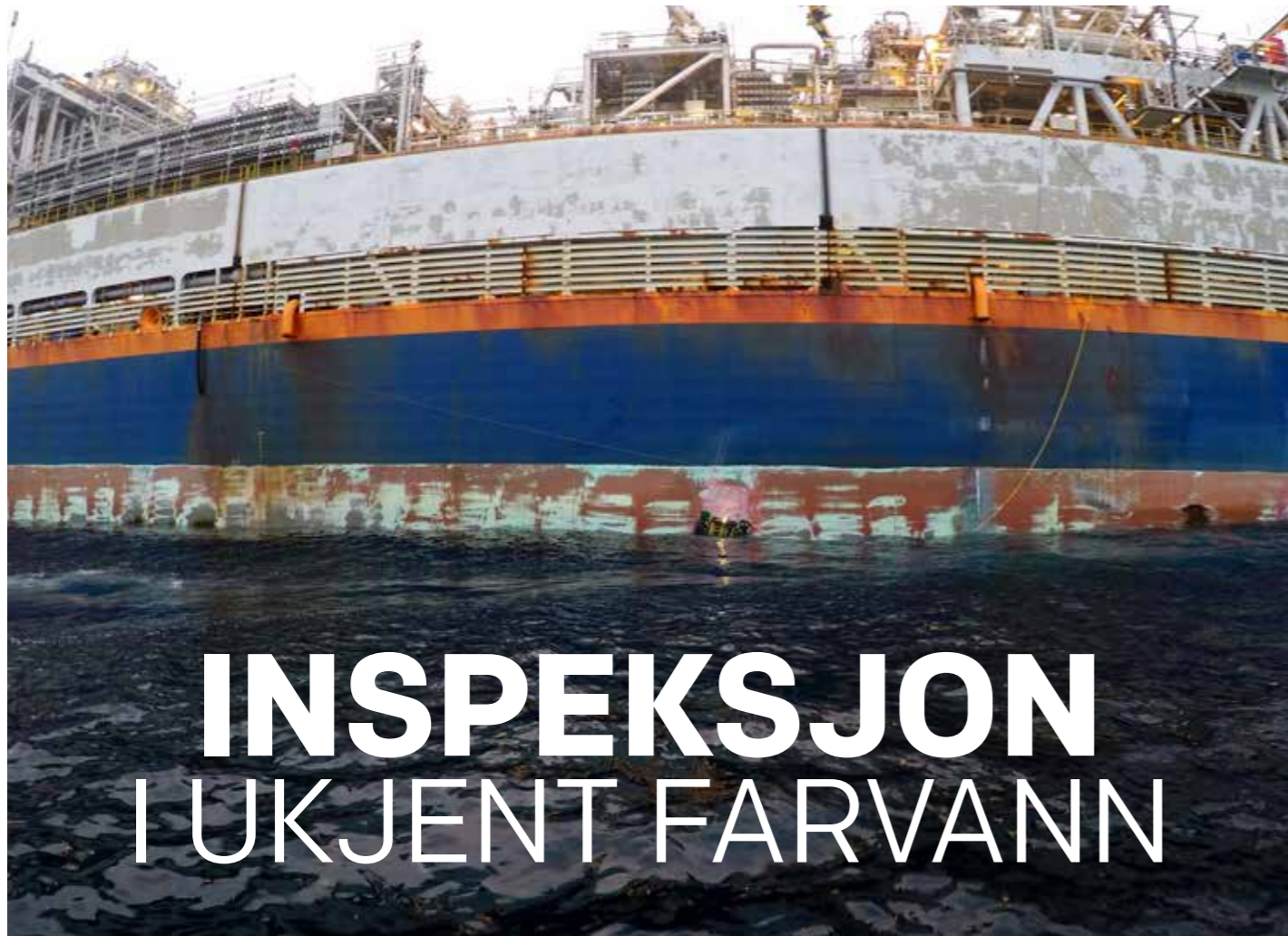
Norne FPSO inspeksjon 2016.
