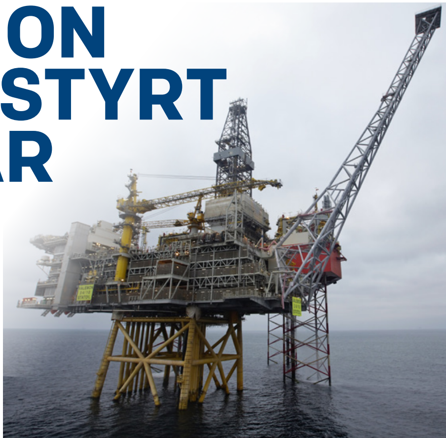
Valemon: Valemon bilde fra borefasen. Borerigg West Elara kan skimtes i bakgrunnen. Kilde: Equinors bildedarkiv
