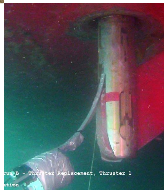
Subsea-bilde av koblingsverktøy tilkoblet løftepunkt og klart for løft.
