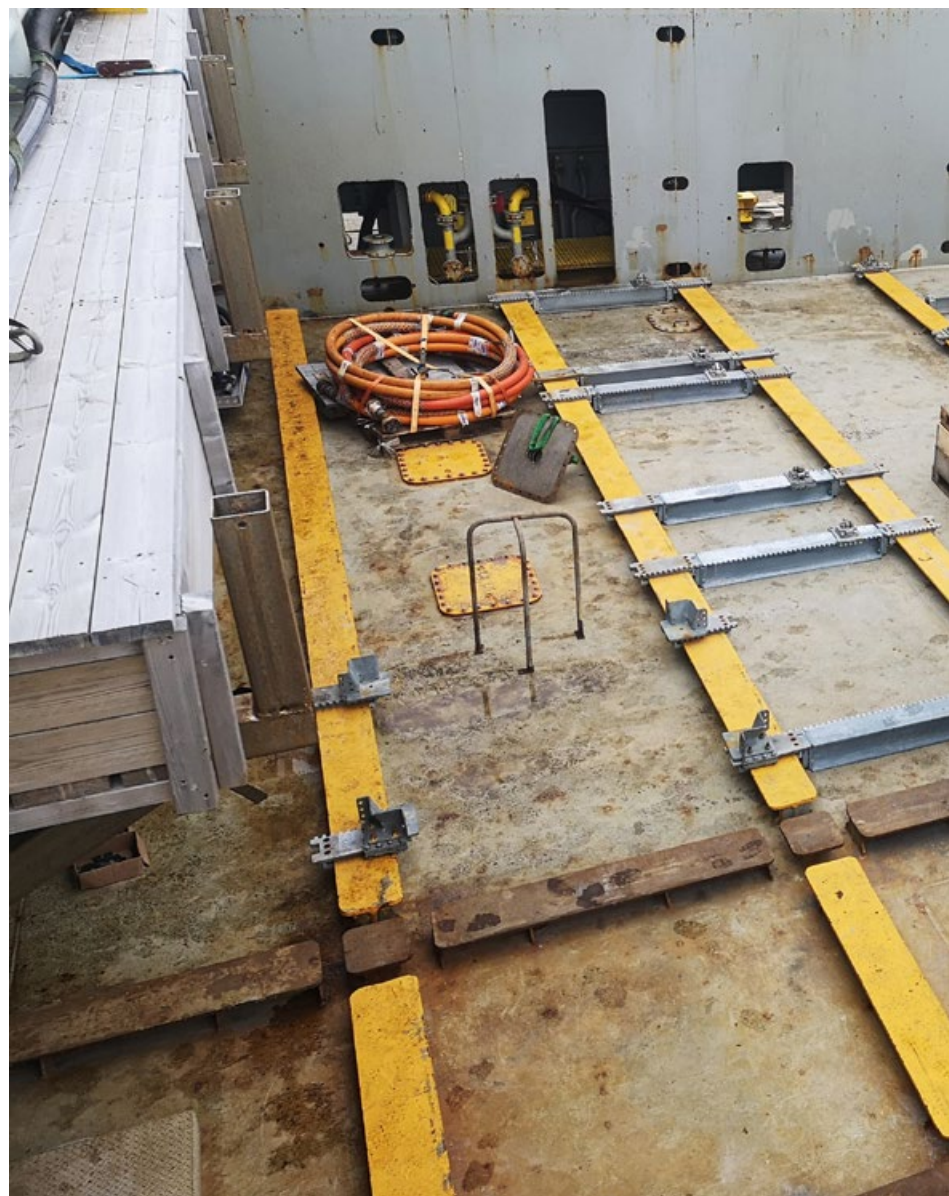
Sveisefri sjøsikring under forberedelse på Island Constructor TIOS.
