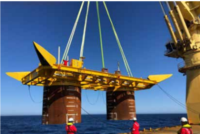
Installasjon av bunnramme i 2019 og manifold i 2020
